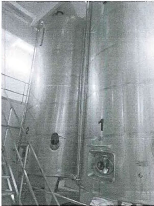
Рис. 2 Ізотермічні бочки з боковою мішалкою об'ємом по 30м3, закуплені у 2022 році
